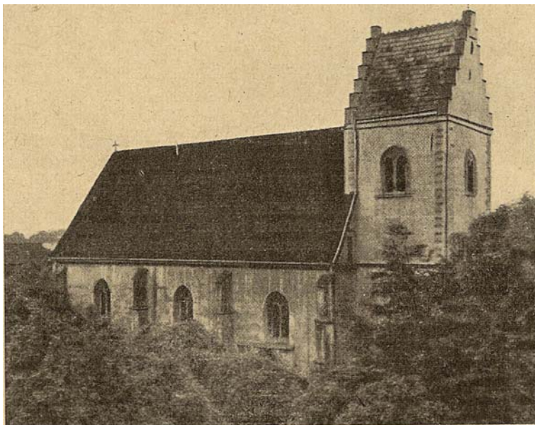
Die alte kath. Kirche bis 1648, heute die ev. Kirche in Mettingen. (ein altes Foto entstanden ca. 1900)
